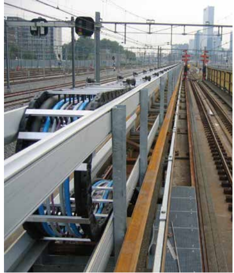
列车清洗示例：室外，风化作用 酸碱环境（洗涤剂） 行程 180 m
